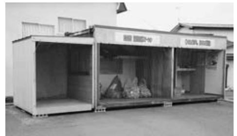
川部ふれあいセンター駐車場内
