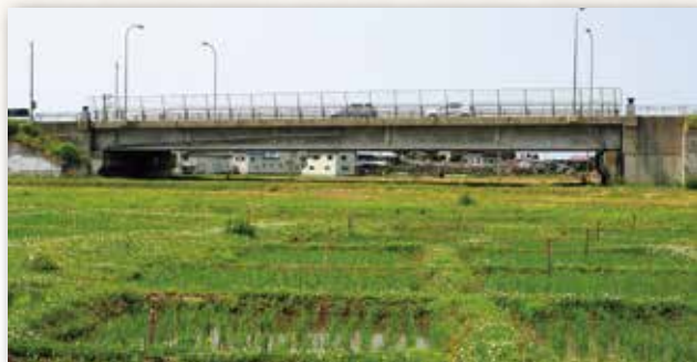
▲埋め戻した遺跡への配慮として、国道102号バイパス道路で採用された空地の高架橋と田植え後の弥生体験田
